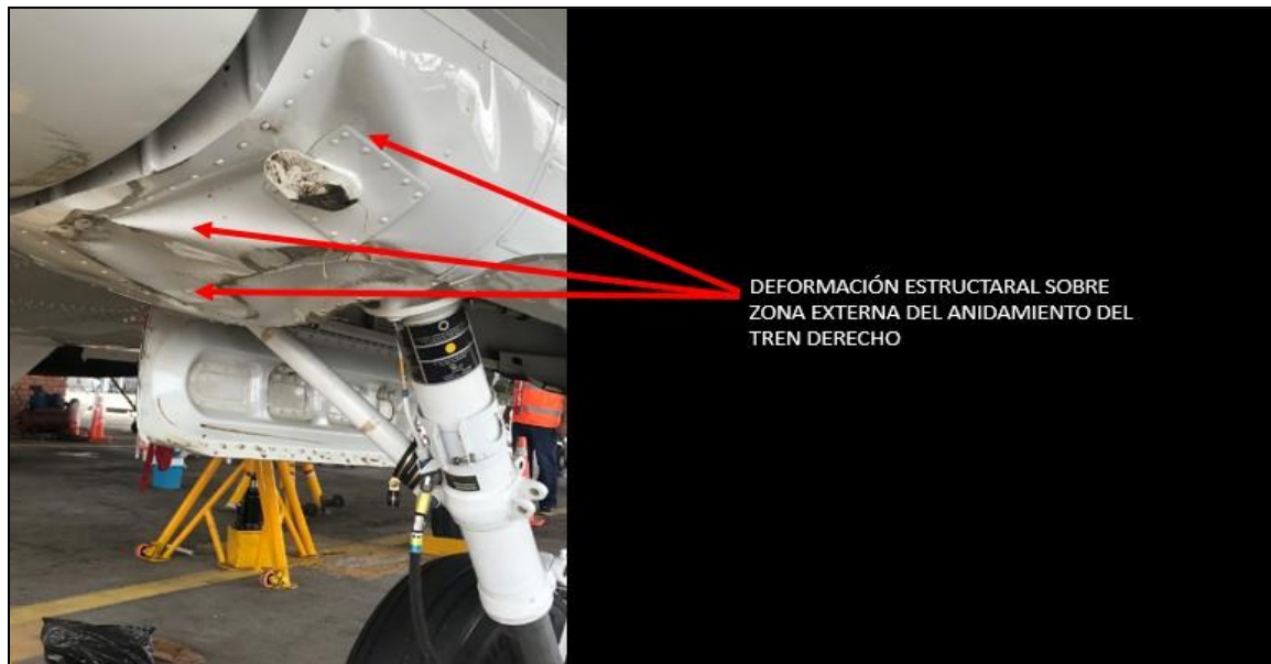
Fotografía No. 7: daños externos sobre el anidamiento tren derecho.
