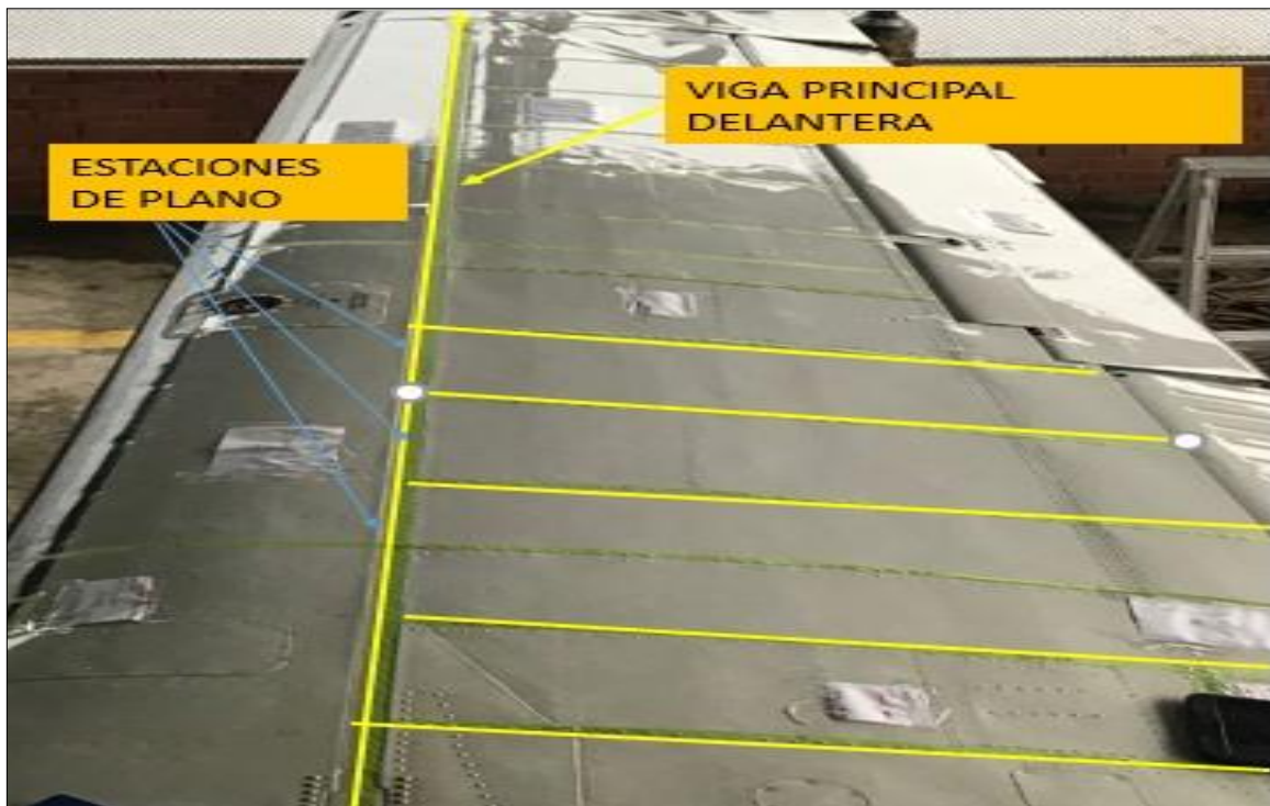
Fotografía No. 3: evaluación de daños en el intradós plano derecho
